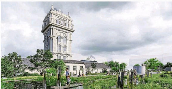
Vinohradskou vodárenskou věž plánuje hlavní město spolu s vodárenskou společností přeměnit na osvětové centrum Hydropolis.
